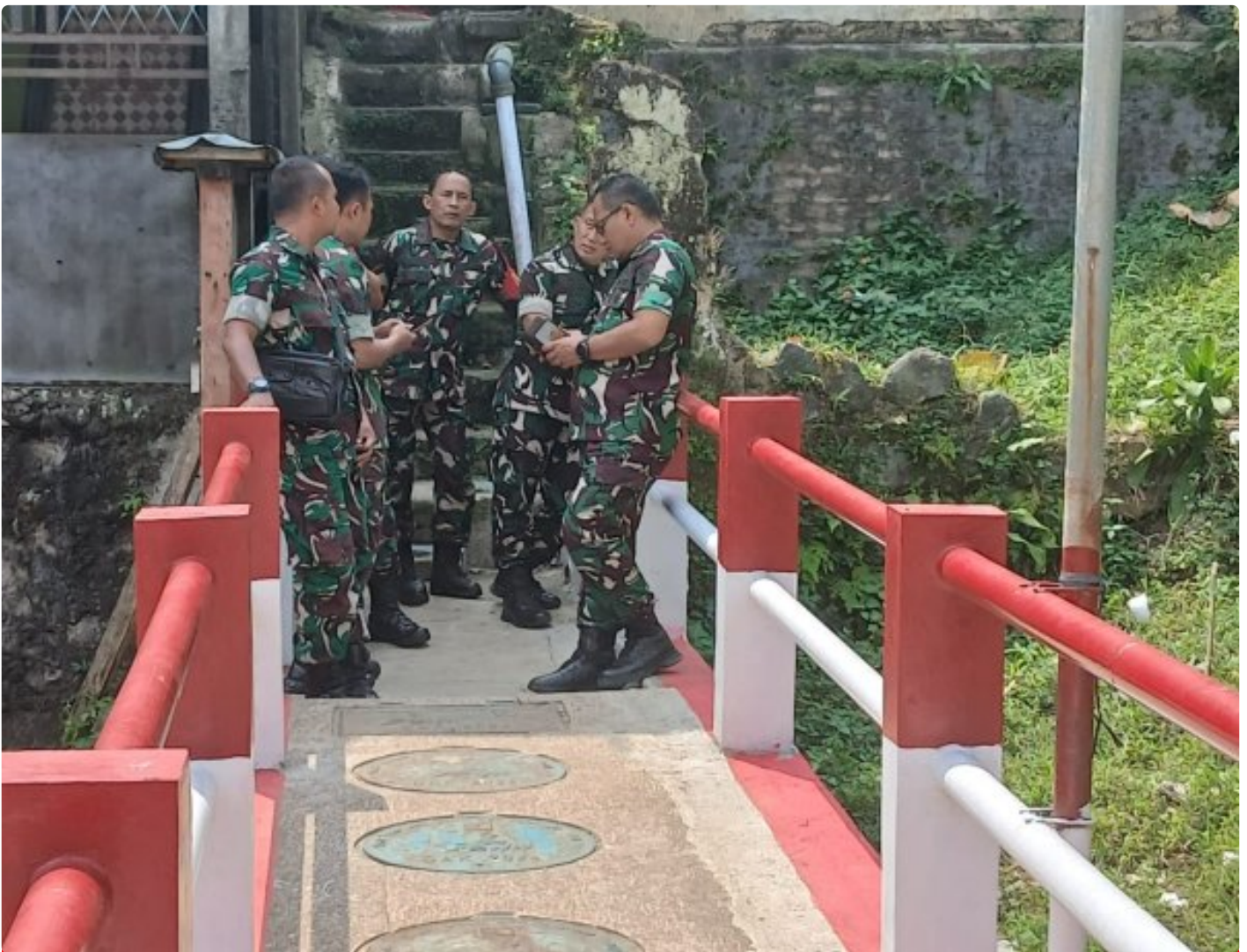
peninjauan lokasi jembatan desa Margajaya
